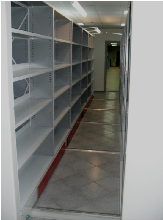
Рис. 4 Механическая защита – плинтус (окрашен в красный цвет) установлен на каждом стеллаже.
